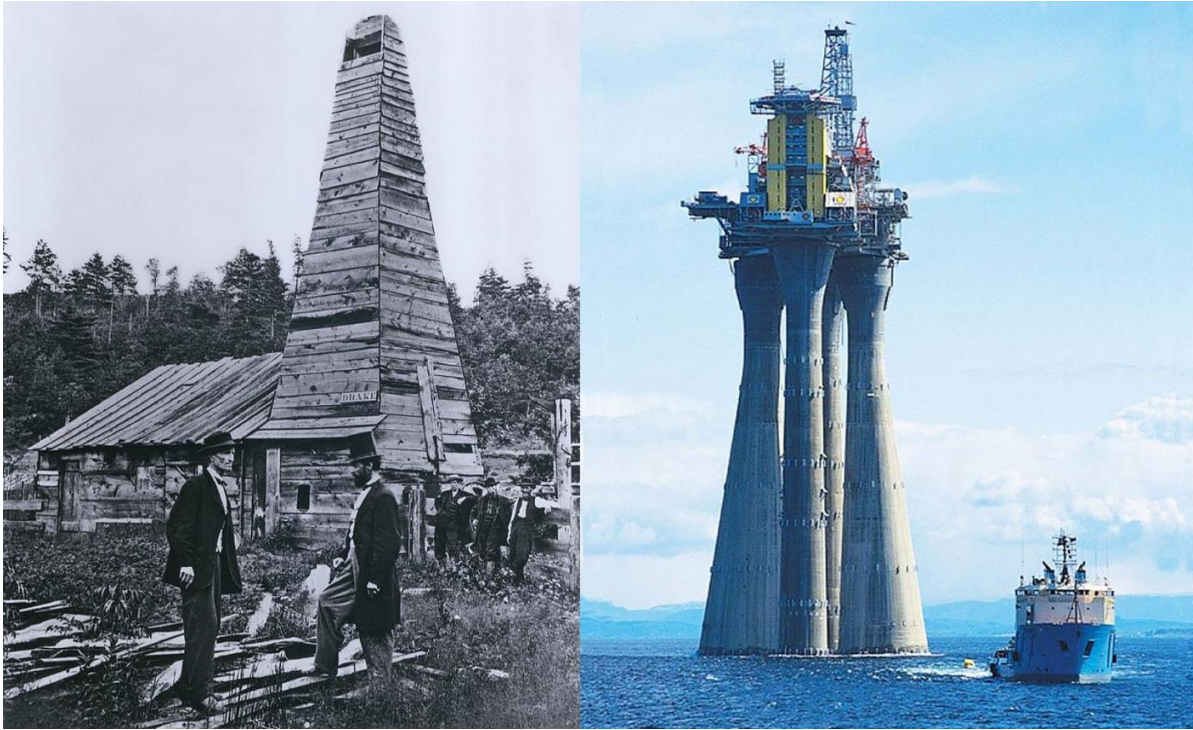
Figure 5 : Forage pour le pétrole et le gaz, hier et aujourd'hui. À gauche, le puits Drake, foré en 1859. Il s'agit du premier puits de pétrole productif aux États-Unis. [Source : AOGHS]. À droite, la structure Troll A (vers 1996), une plate-forme de gaz naturel au large de la Norvège. C'est la plus haute structure jamais déplacée par l'humanité. [Source : datis-inc.com].
